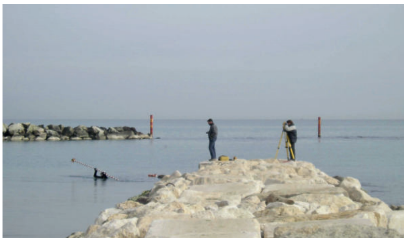
Figura 16. Rilievi topo-batimetrici al termine dei lavori di riqualificazione funzionale delle opere di difesa in località Igea marina
