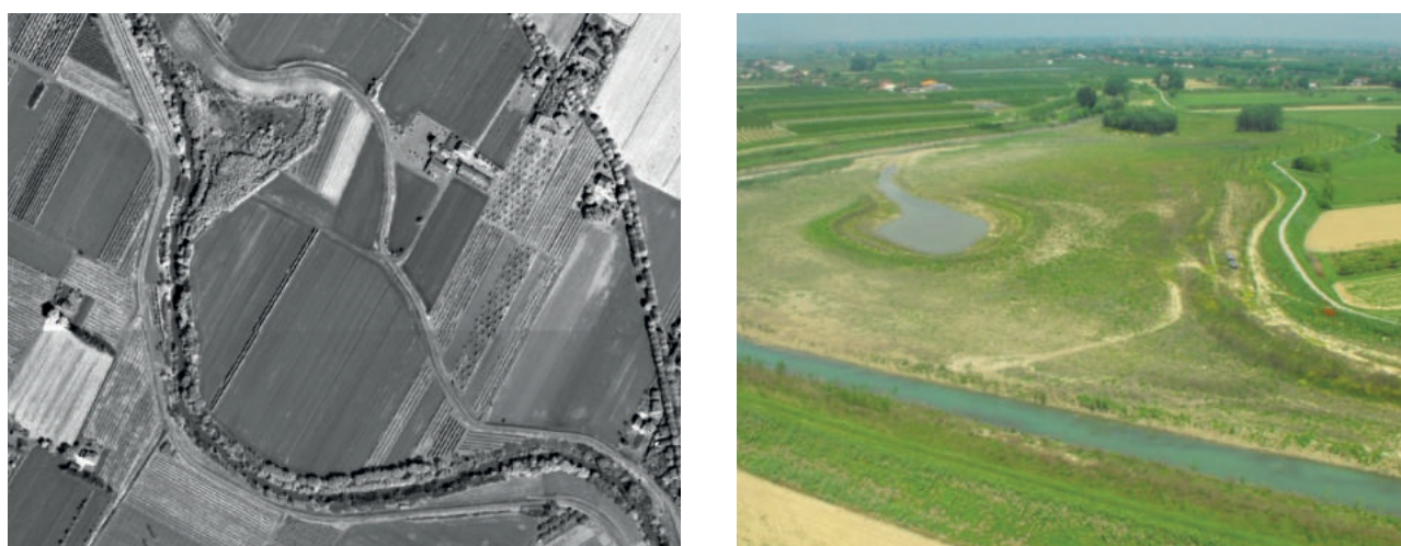
Figura 26. Lavori cassa fiume Montone (S.Tomè - Villafranca di Forlì)
