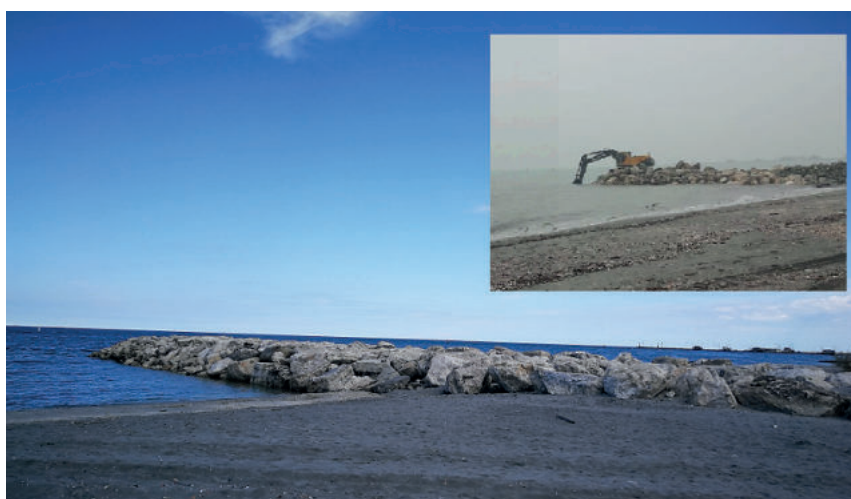
Figura 19. Salpamento scogli per accorciamento del pennellone
