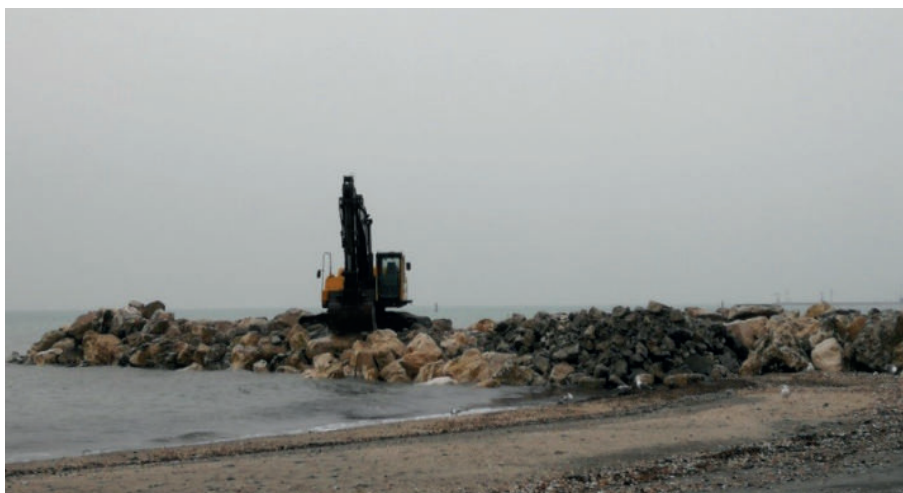
Figura 21. Lavori di riassetto del sistema di difesa della spiaggia di Ponente - Cesenatico
