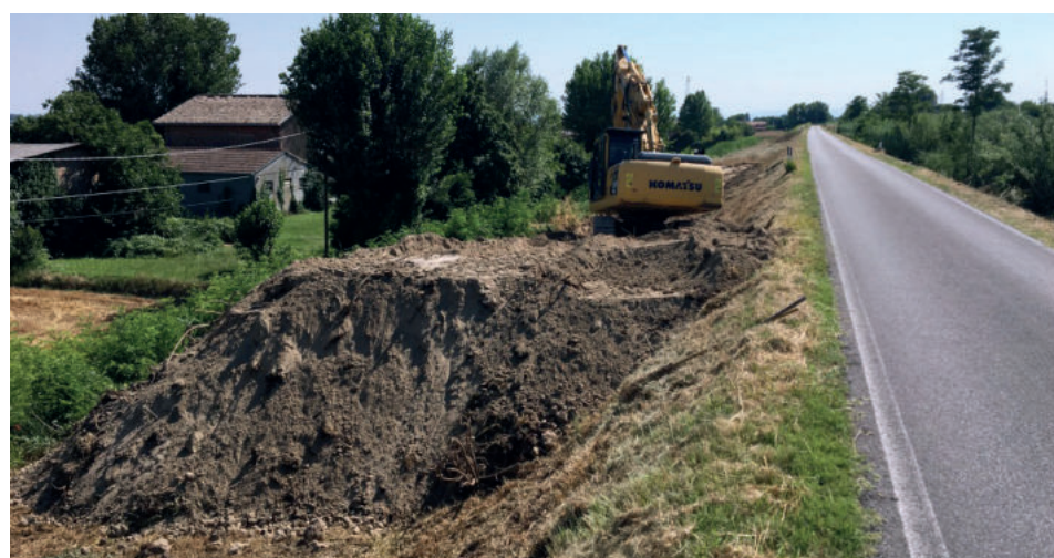
Figura 6. Frana argine destro fiume Montone, in località San Marco, nel comune di Ravenna
