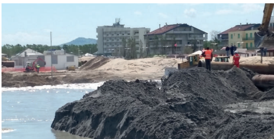
Figura 28. Spiaggia di Misano adriatico, fasi delle lavorazioni a terra per il refluito del materiale proveniente dai depositi ad oltre 55 km al largo
