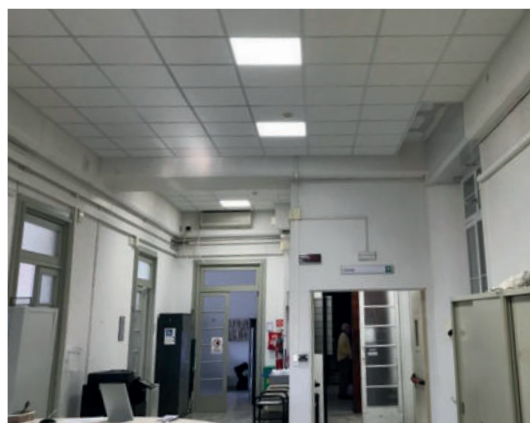
Foto 3. La sede di Forlì, locali interni dopo i lavori
