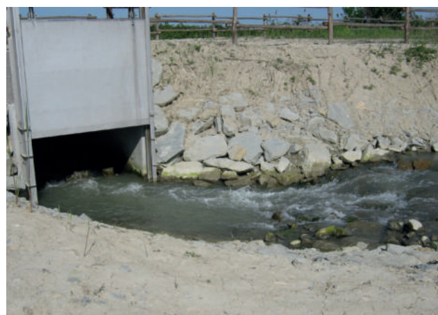
Foto 3. Scala di risalita per i pesci sul fiume Lamone a Bagnacavallo (Ra)
