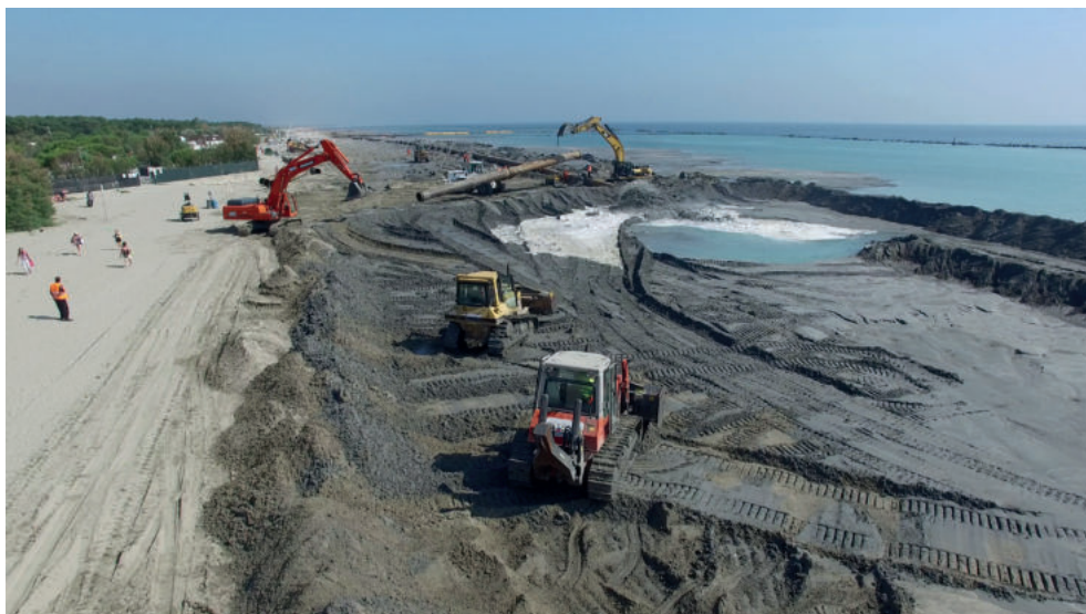
Figura 30. Progettone 3: lavori sulla spiaggia di Punta Marina
