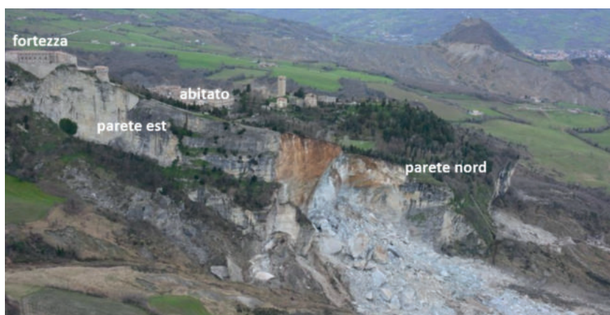
Figura 8. Panoramica del crollo dello spigolo nord-est della Rupe di San Leo del febbraio 2014
