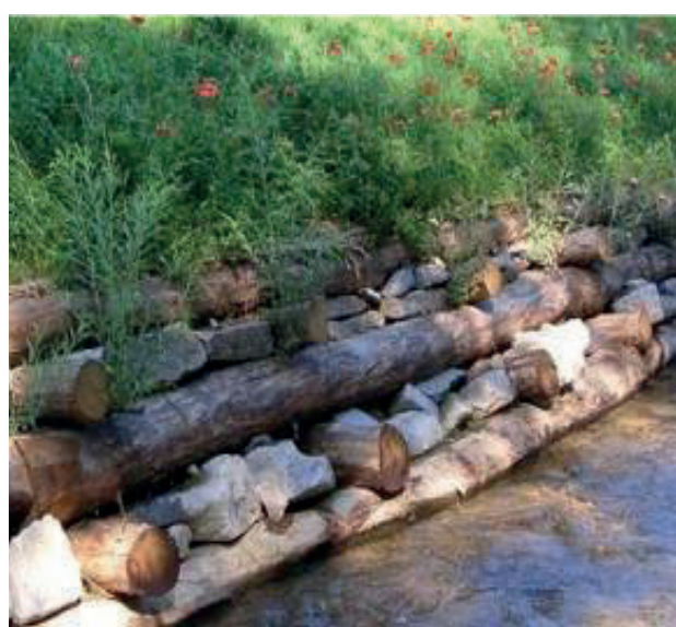
Figura 18. Tipologie di difese spondali con opere ingegneria naturalistica (Lamone)
