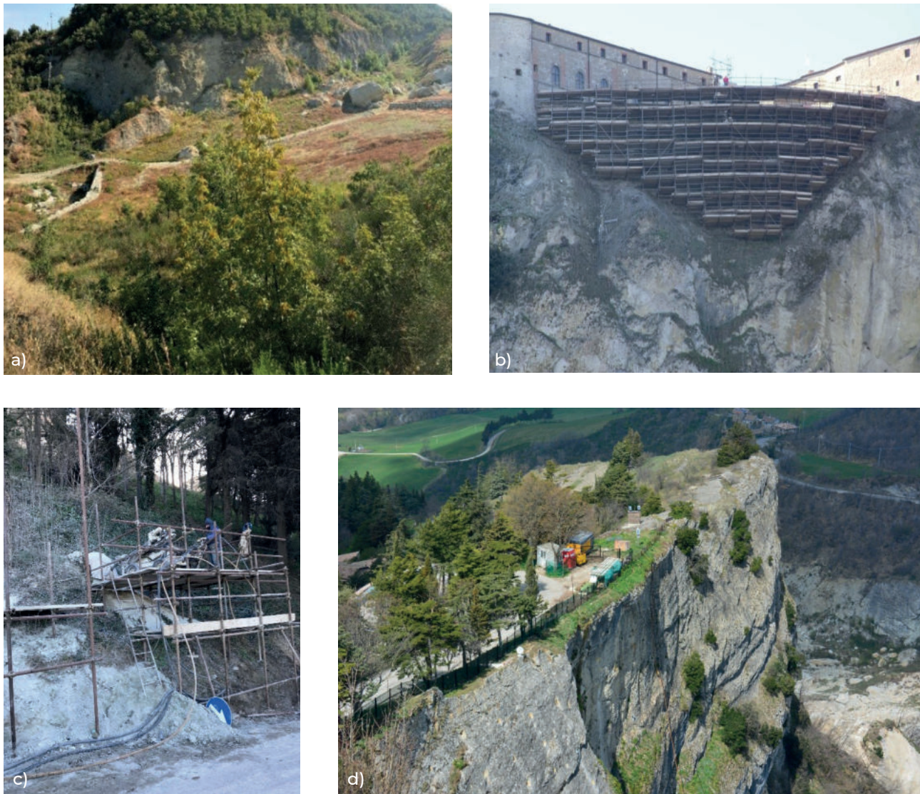
Figura 10. Immagini di alcuni degli interventi eseguiti per il consolidamento della Rupe di San Leo: a) interventi nel Fosso Campone per il contenimento della coltre detritica ai piedi della parete del crollo 2014; b) interventi di consolidamento delle mura del 3° piazzale della fortezza e della porzione di parete sottostante; c) parete est della Rupe oggetto di interventi di consolidamento per la messa in sicurezza della strada di accesso alla fortezza; d) lavori di consolidamento in corso della parete est della Rupe di san Leo lungo la strada di accesso alla fortezza
