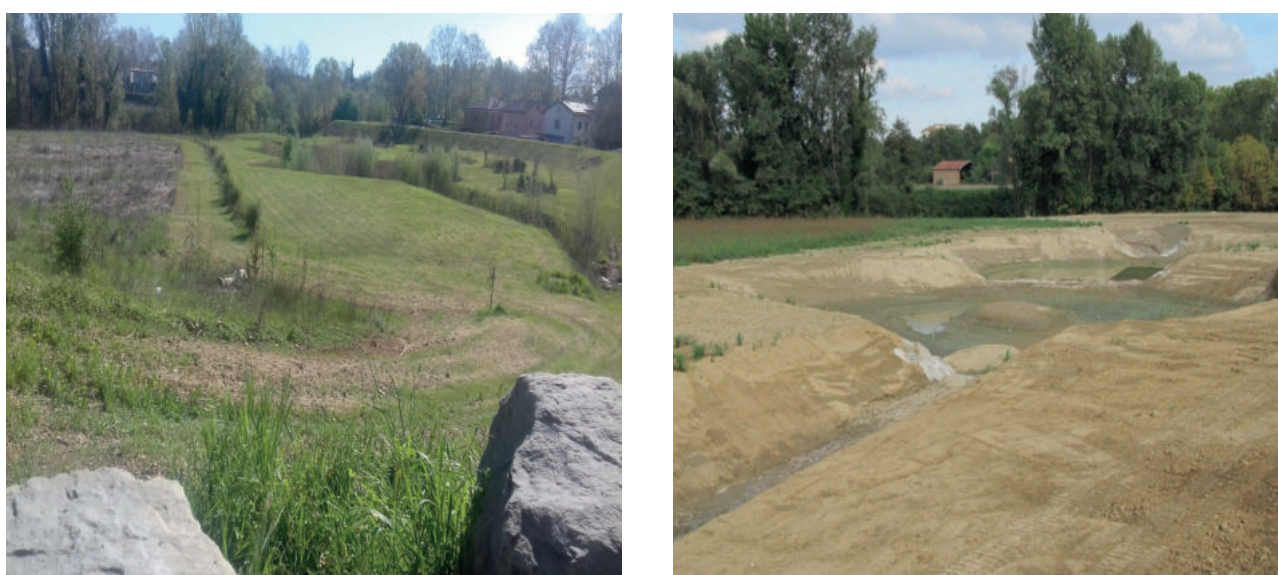
Figura 27. Lavori area fitodepurazione rio Ronco Vecchiazano
