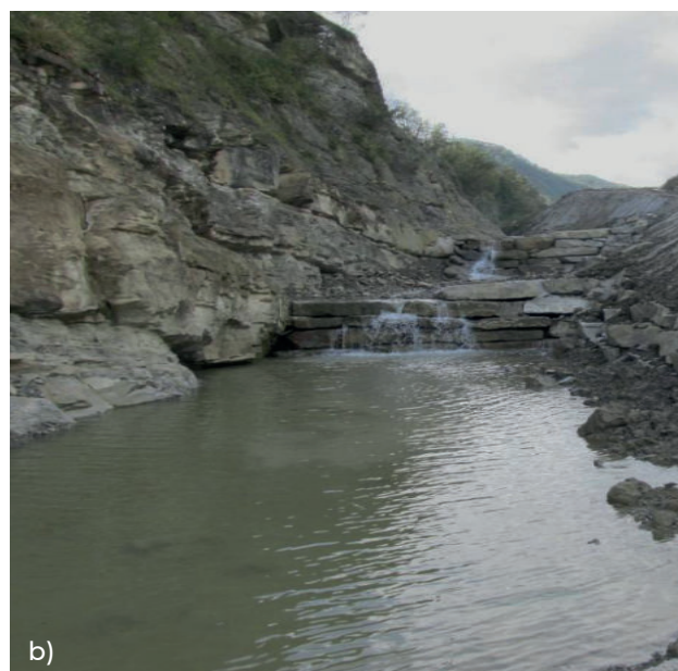
Figura 6. a) Immagine aerea della grande frana di Poggio baldi; b) corso del fiume Bidente dopo i lavori di sistemazione
