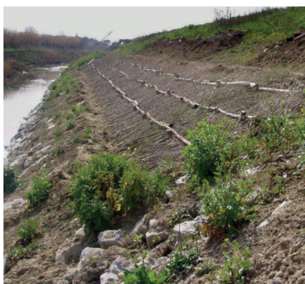
Figura 18. Tipologie di difese spondali con opere ingegneria naturalistica (Lamone)
