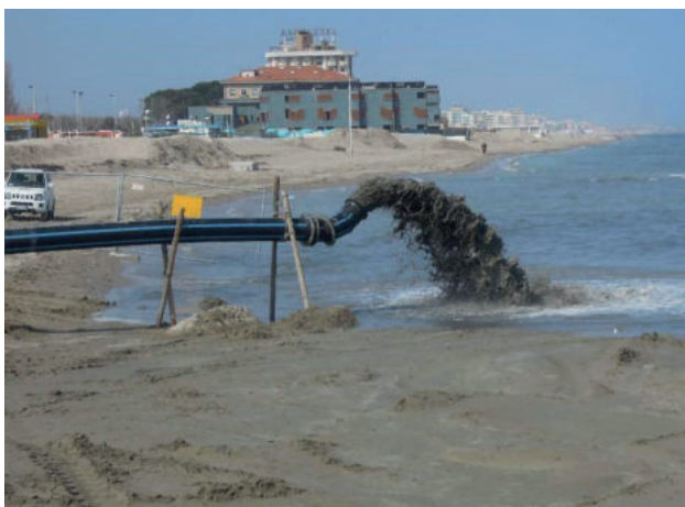
Figura 24. Novembre 2013: inaugurazione dell'impianto alla presenza dell'assessore Gazzolo e del sindaco Pironi. In basso: funzionamento dell'impianto. Scavo del materiale con la draga presso l'imboccatura del porto e refluito sulla spiaggia di Riccione sud ad una distanza di 3,3 km dal punto di prelievo
