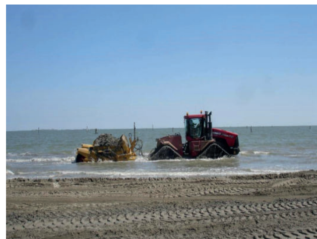
Figura 11. Recupero sabbia dai bassi fondali tramite mezzi "Scraper" e utilizzo a fini di ripascimento
