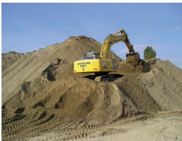
Figura 10. Riutilizzo a fini di ripascimento delle sabbie ottenute dalla vagliatura del materiale spiaggiato e da scavi edili in ambito litoraneo dopo una mareggiata
