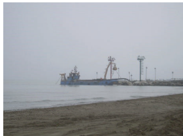
Figura 24. Novembre 2013: inaugurazione dell'impianto alla presenza dell'assessore Gazzolo e del sindaco Pironi. In basso: funzionamento dell'impianto. Scavo del materiale con la draga presso l'imboccatura del porto e refluito sulla spiaggia di Riccione sud ad una distanza di 3,3 km dal punto di prelievo
