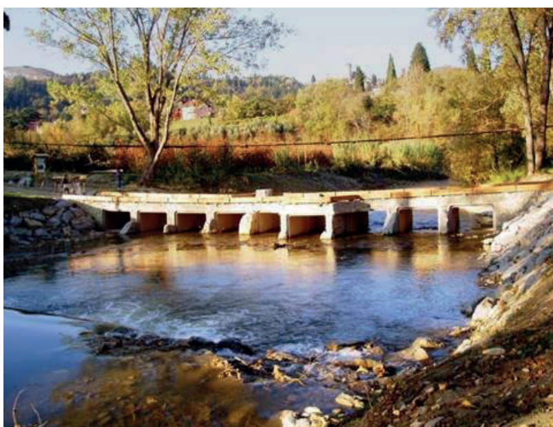
Figura 19. Guado ciclopedonale fiume Lamone
