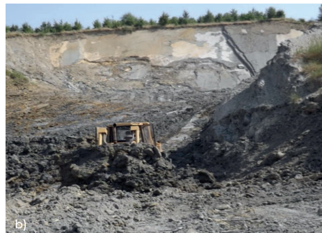
Figura 7. a) Panoramica dell'area di nicchia della frana; b) Lavori di sistemazione e di consolidamento della frana in corso d'opera
