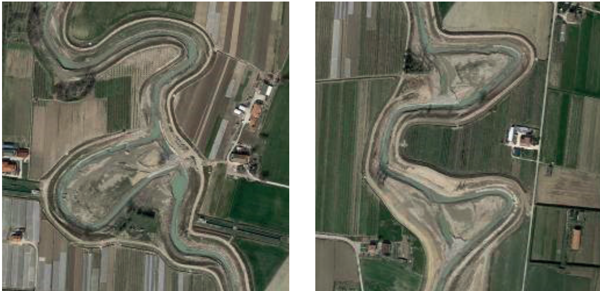
Figura 28. Lavori fiume Uso (Rimini-S.Mauro)
