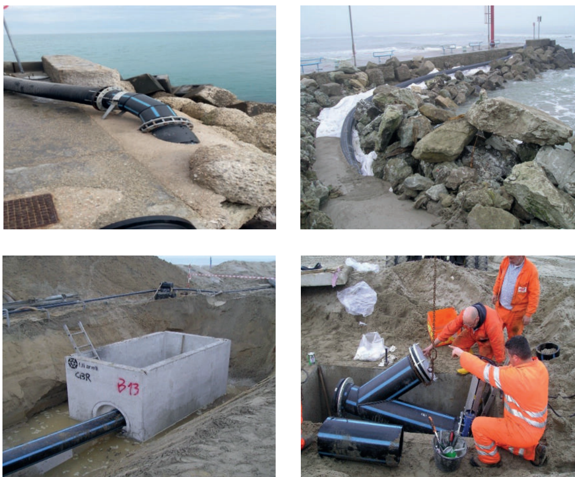
Figura 23. Lavori di realizzazione del sabbiodotto permanente e interrato sulla spiaggia di Riccione. In alto: punto di innesto e primo tratto di condotta sul molo di levante; in basso: pozzetti e pezzi speciali di derivazione
